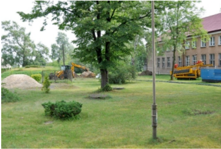
Foto 3. Espacio libre para la perforación con la geología e hidrología adecuado para la perforación
