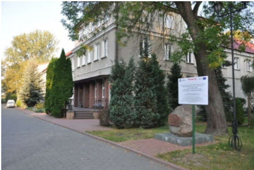
Foto1. La elevación Antigua y ventanas
