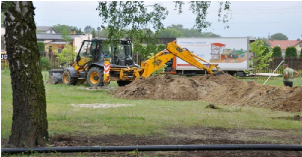
Foto 5. Instalación de la tubería horizontal
